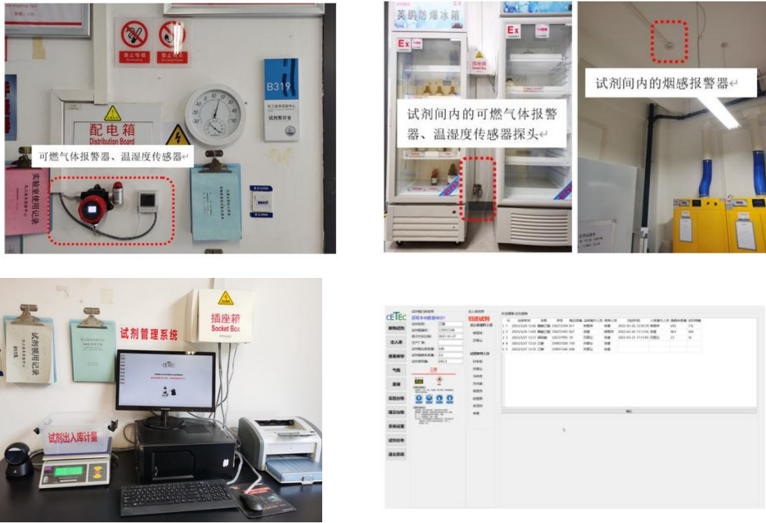
图 11 试剂暂存室的环境参数报警监控及化学试剂台账管理系统
